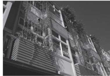
写真 7, 8 A 幼稚園：園舎外壁エコ改修。珪藻土壁、壁面緑化（左：改修前、右：改修後）
