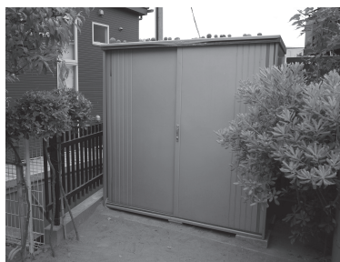
④維持管理施設：倉庫
