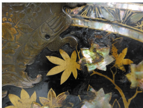
図7 正面 鍍金具 鍍金の紛失部分
