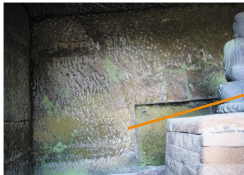
↑奥壁 奥壁や左壁に常に見られる白色 の析出物は、硬い殻状である
