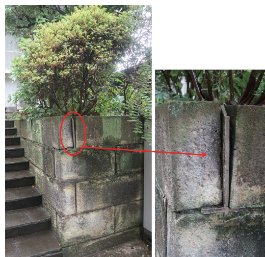
図8. 亀裂の増大
