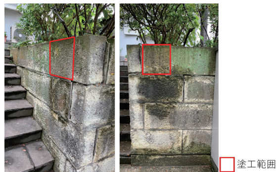
図 24. 雨上がりの塗工箇所周辺の状態
