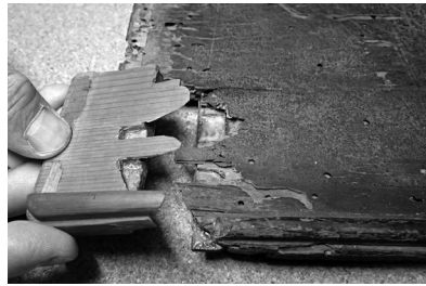
図10 補材の接着
